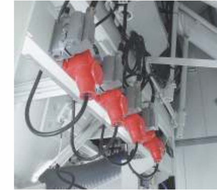
Tomadas elétricas de engate rápido facilitam a montagem e desmontagem da central.
